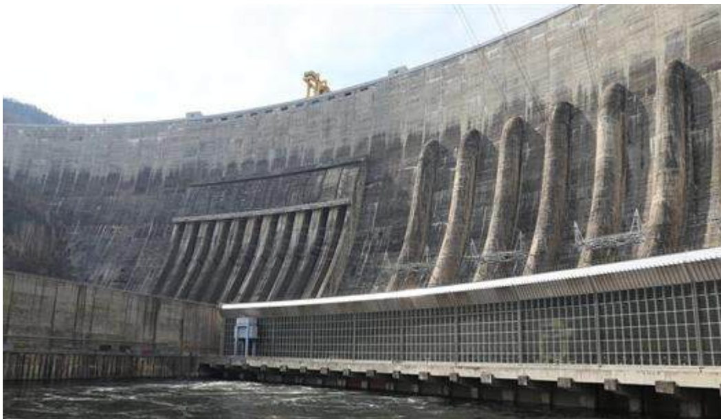
Рисунок 2. Плотина Саяно-Шушенская ГЭС
