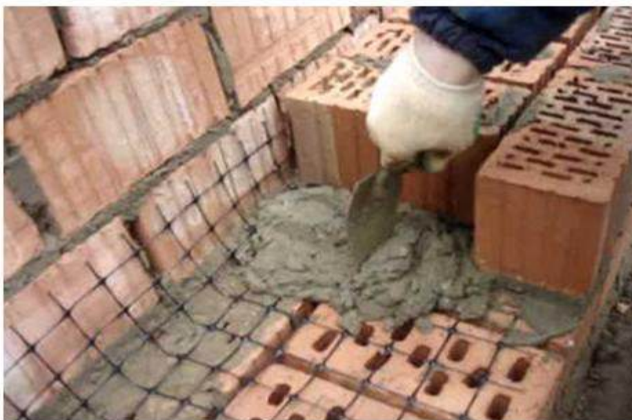
Рис. 3- Применение пластиковой сетки при укладке пустотелого кирпича
