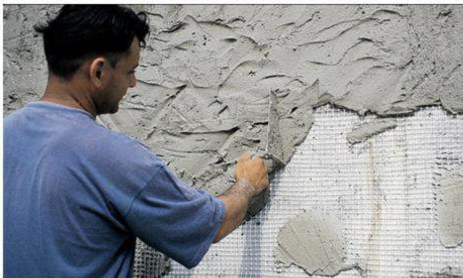
Рис. 2- Использование полимерной сетки при штукатурных работах
