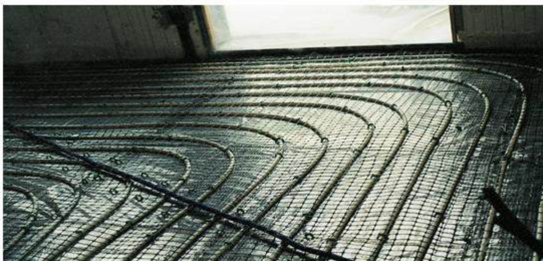
Рис. 4 – Применение сетки при бетонировании пола
