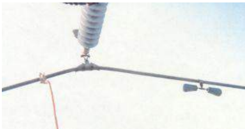
Рисунок 3 – Гаситель вибрации на проводе
